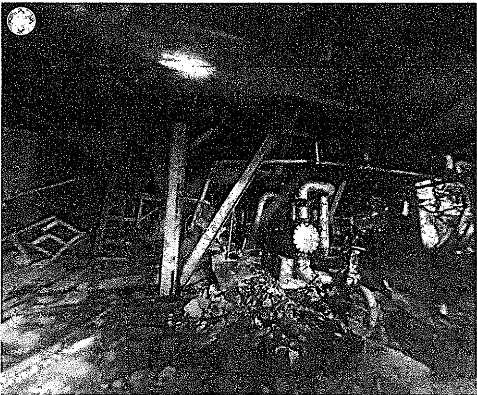
事故後初めて撮影された東京電力福島第1原発3号機4階。がれきが散乱しているが、機器に大きな損傷はみられない＝9月18日、原子力規制庁撮影
