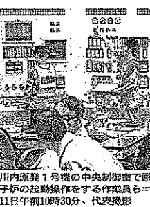
川内原発1号機の中央制御室で原子炉の制御操作をする作業員ら。11日午前10時30分、代表撮影
