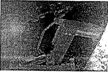
圧力容器を支える台座の入り口付近から、下方向を撮影。事故前にあった足場は確認できませんでした(19日(国際発研 究開発機構提供))
